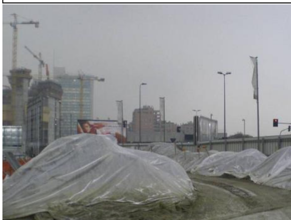
Protezione con teli delle terre di scavo
